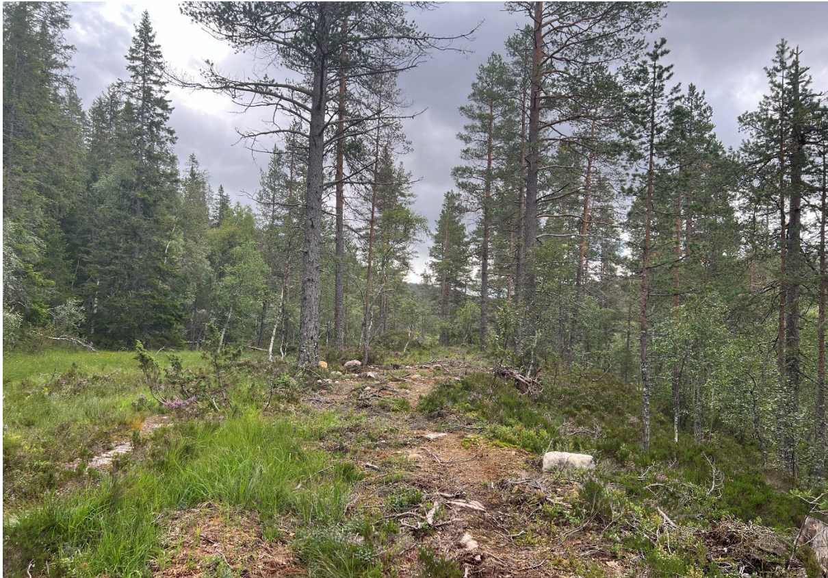
Figur 6 Bilde fra planområdet ved traktorvegen som bygges
