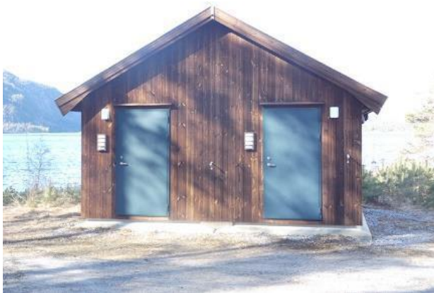
Figur 18 Pumpestasjon for vann og for avløp i samme bygg på Kroknes
