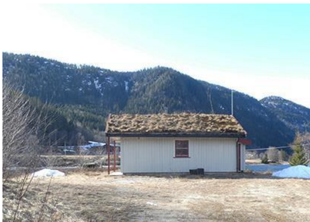
Figur 6 Vannbehandlingsanlegget på Ose
