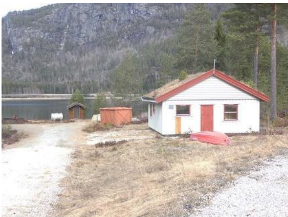
Figur 14 Bygland vannverk med inntakspumpestasjon i bakgrunnen.
