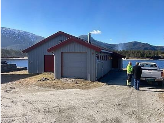
Figur 22 Vannverket ved Byglandsfjord
