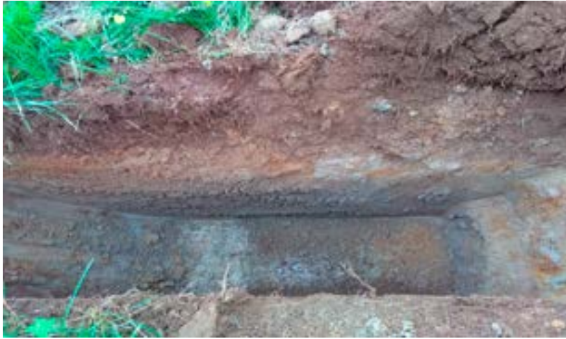
Figur 3.6: Sjakting med gravemaskin - lagdeling over tette masser
