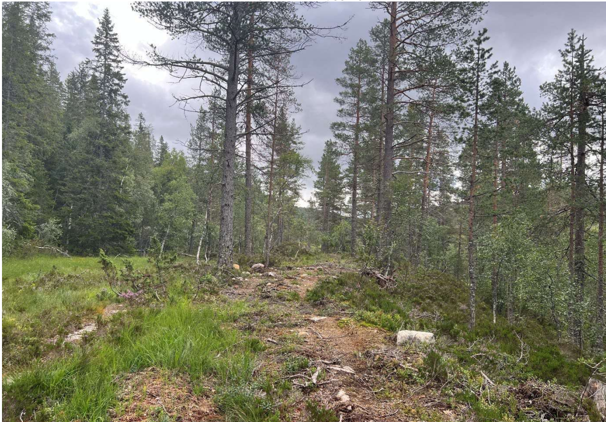
Figur 6 Bilde fra planområdet ved traktorvegen som bygges
